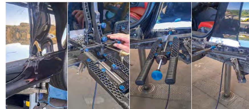
Das Instandsetzen von Aluminium-Seitenwänden ist nicht Jedermanns Sache. Karosserie-Trainer Klaus Dollas von Carbon hat bei der CBR-Vorführung per „Learning by doing“ mit den Störk-Mitarbeitern gleich zwei Seiten- und Schwellerschäden repariert.
