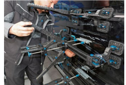
Hervorragende Kontrolle bei der Instandsetzung durch erweiterte Zugmöglichkeiten mit StrongTool, dem kurzen sowie dem langen LineTool
